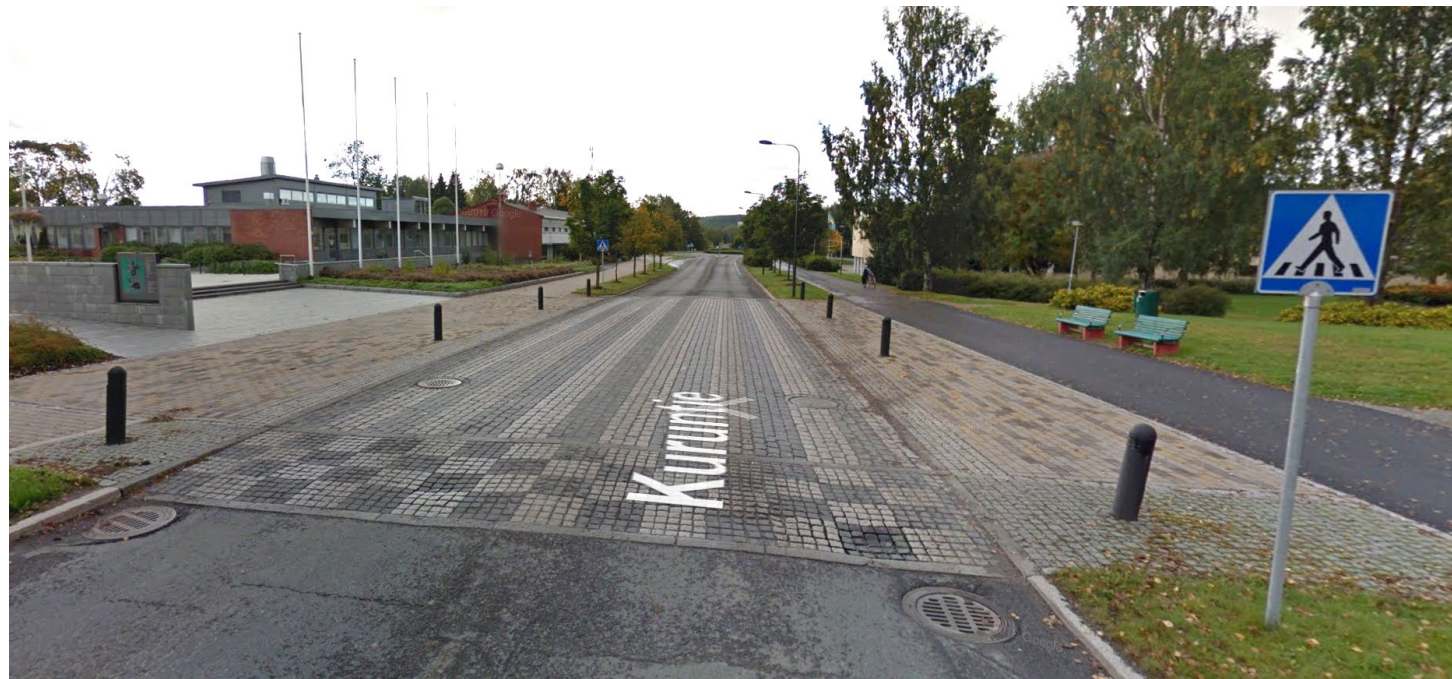
Kuva: Esimerkki leveästä korotetusta suojatiestä Kuruntielle, Ylöjärvellä.
